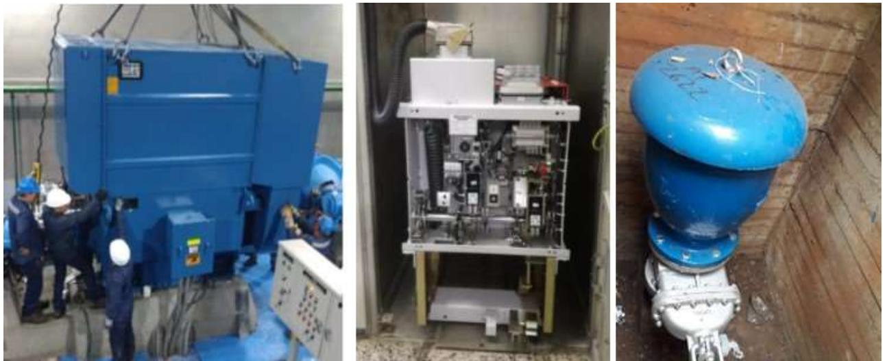
Reparación del bobinado estático del motor de la unidad N° 4 del bombeo Bosconia \$213.900.001
