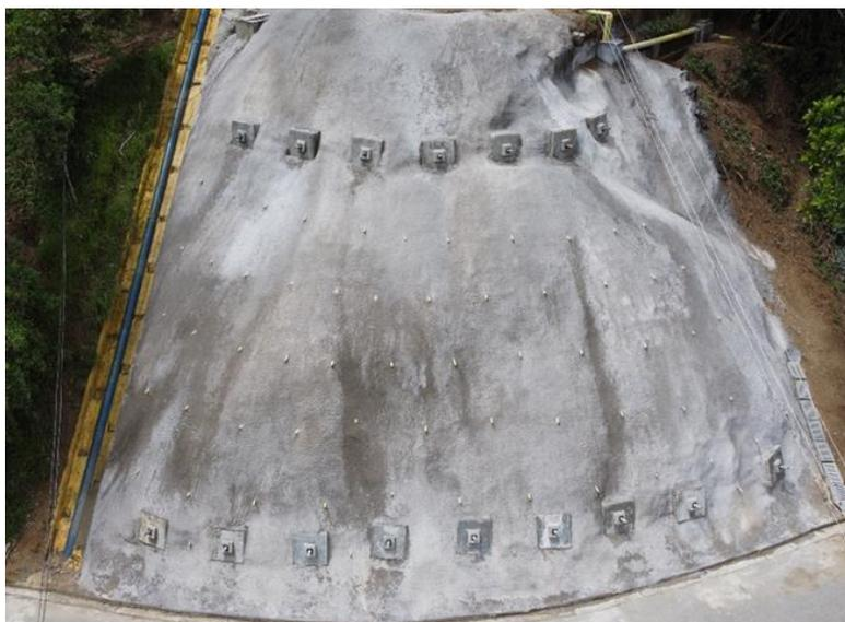
FIGURA 160. OBRAS DE ESTABILIZACIÓN DEL SITIO CRITICO NÚMERO 1 EN EL K18+00 DEL CANAL DE ADUCCIÓN
