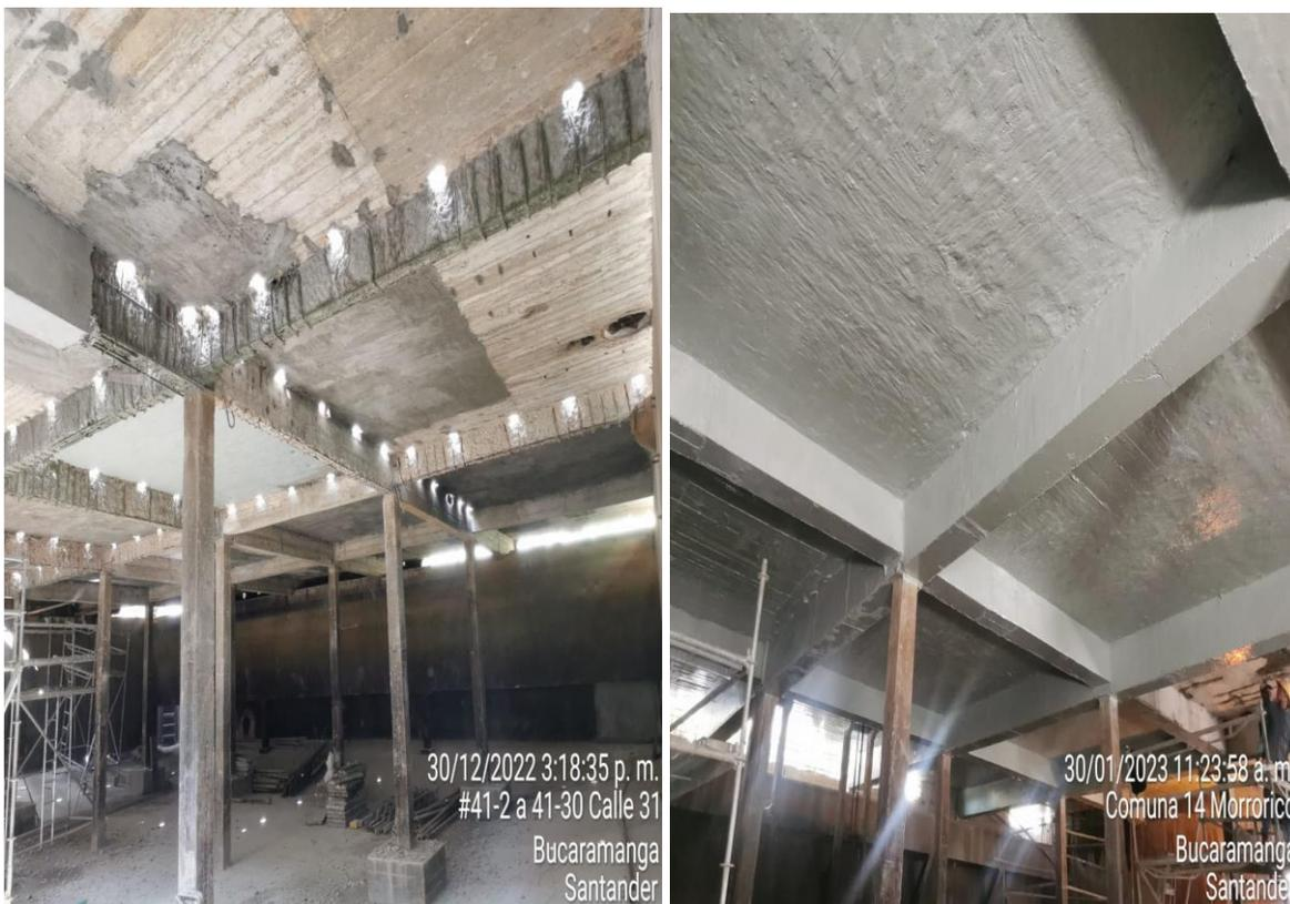
**FIGURA 30. REFORZAMIENTO ESTRUCTURAL DEL TANQUE DE ALMACENAMIENTO NORTE BAJO (POIR 33.1)**
