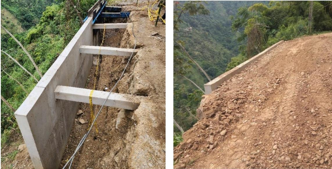
FIGURA 161. CONSTRUCCIÓN DE MURO ARRIOSTRADO K 6+800
