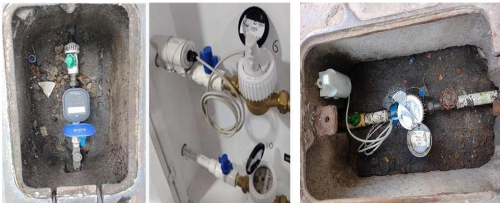
FIGURA 64. IMAGEN DE MEDIDOR ULTRASÓNICO Y MECÁNICO EN APTO Y CAJILLA PISO CON EQUIPOS DE TRANSMISIÓN
