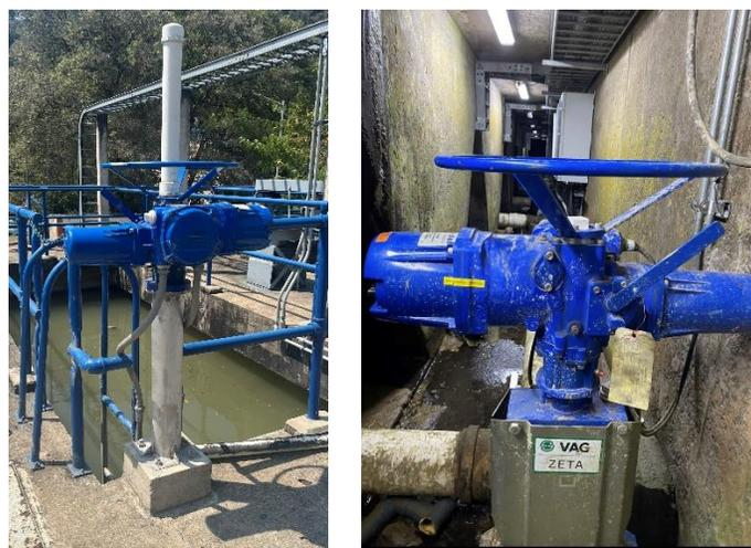
FIGURA 167. ACTUADORES Y VÁLVULAS DE OPERACIÓN AUTOMÁTICA EN CAPTACIÓN Y DESAGÜE DE FLOCULADOR BOSCONIA
