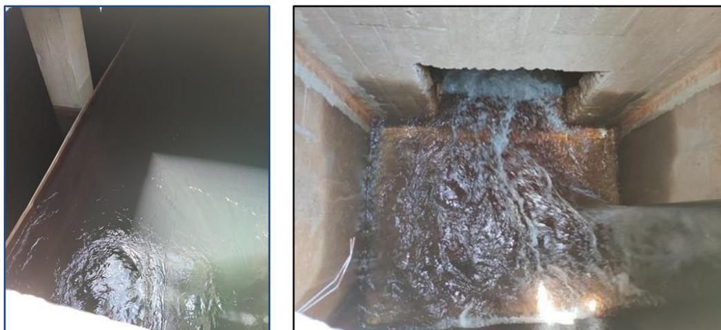
FIGURA 172. SALIDA Y ENTRADA DEL TANQUE DE CONTACTO DE CLORO DE LA FLORA
