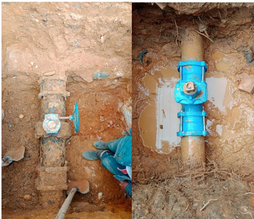
**FIGURA 27. SUMINISTRO DE INSTALACIÓN DE VÁLVULAS Y TAPAS DE SEGURIDAD PARA LA SECTORIZACIÓN DE LOS DISTRITOS HIDRÁULICOS NORTE, MORRO ALTO Y ESTADIO DE BUCARAMANGA (POIR 5.5)**
