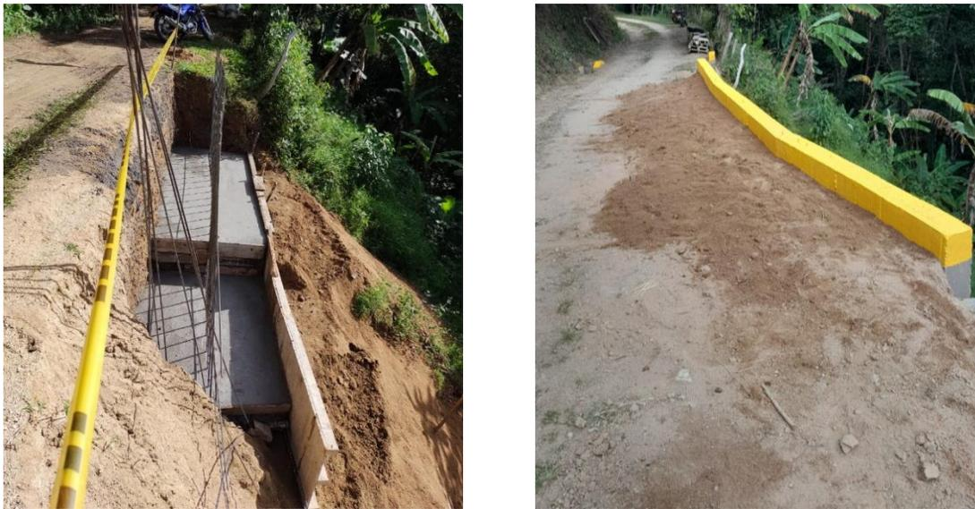
FIGURA 162. CONSTRUCCIÓN DE MURO TIPO CANTILEVER, ACCESO A LA CAPTACIÓN ARNANIA
