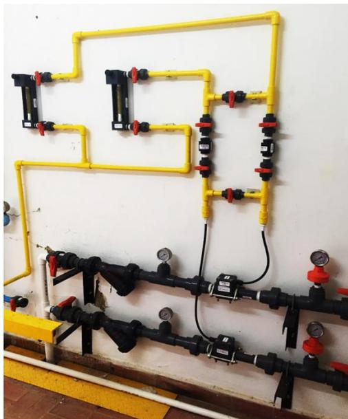
FIGURA 170. SISTEMA DE CLORACIÓN DE LA PLANTA FLORIDABLANCA
