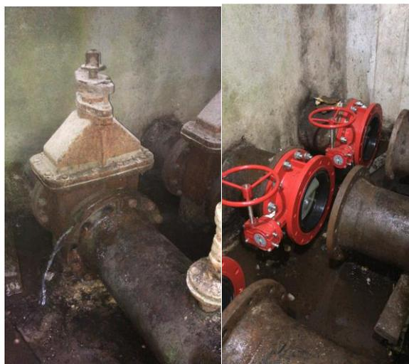
FIGURA 26. SUMINISTRO E INSTALACIÓN DE VENTOSAS Y VÁLVULAS EN LAS CONDUCCIONES DEL amb (POIR 5.5) VÁLVULAS DE SALIDA CONDUCCIÓN PAN DE AZÚCAR
