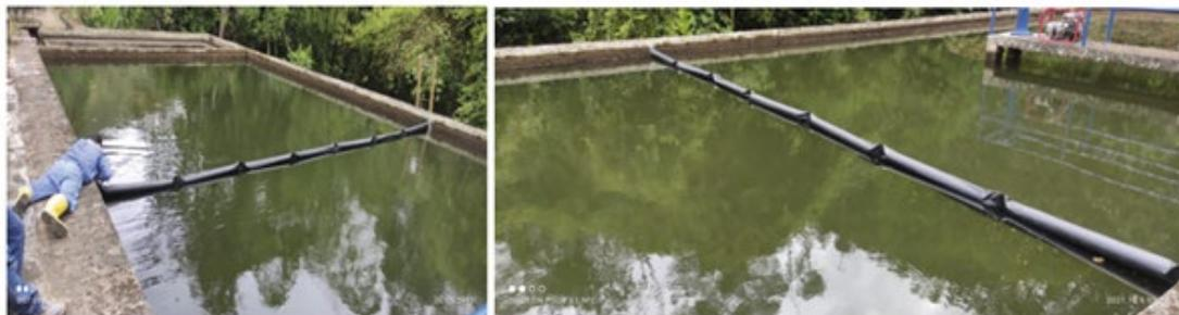
Figura 67. Instalación de barreras anti derrames en los desarenadores del Sistema Tona
