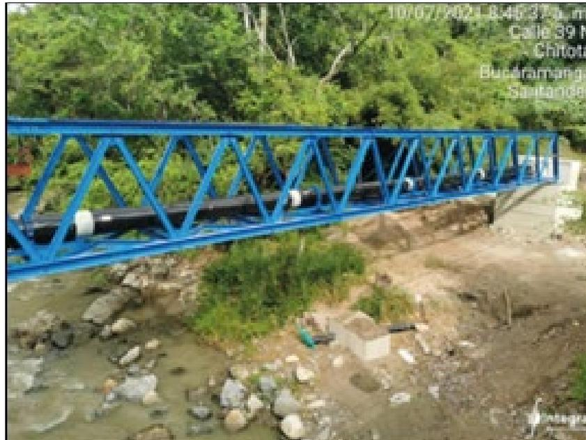
Figura 16. Paso elevado Bosconia e de instalación tubería GRP biaxial canal Zaragoza
