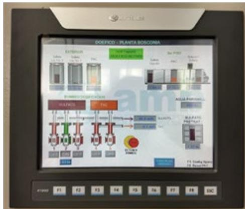
Figura 63. PLC de integración de los sistemas de dosificación de coagulantes líquidos
