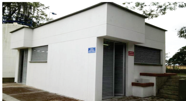
Cuarto de Almacenamiento temporal de Residuos de la Planta la Flora
