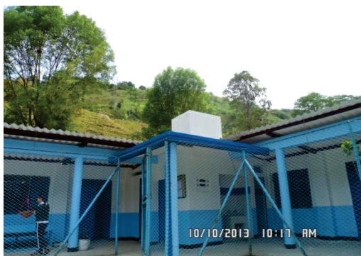
Reparaciones Locativas Escuela Golondrinas
