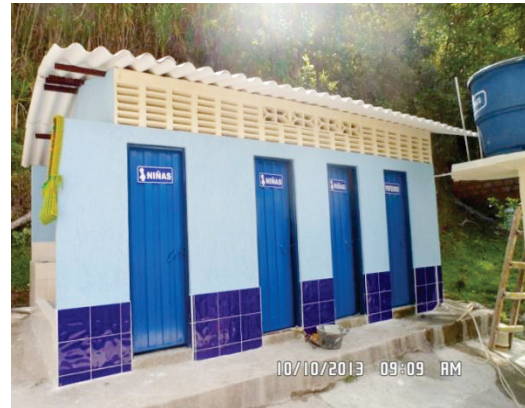
Reparaciones Batería de Baños Colegio Rafael Uribe - Tona
